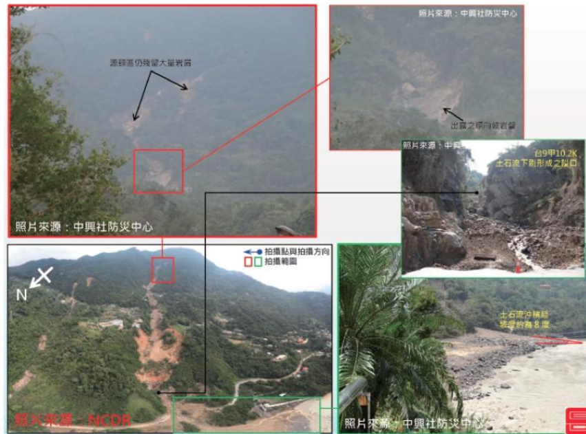
忠治里許多崩塌地可看到岩盤裸露，仍有大量土砂堆積 (圖片來源_財團法人中興工程顧問社)
